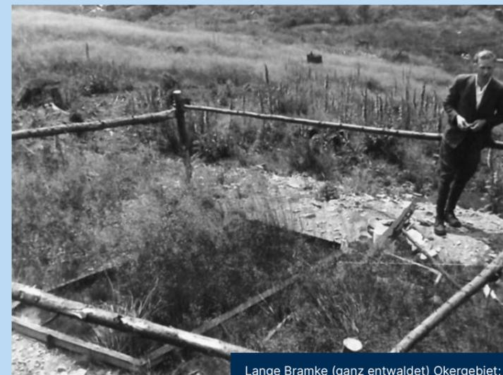
Lange Bramke (ganz entwaldet) Okergebiet; Versuchsfläche zur Messung des Oberflächenabflusses einer bewachsenen Fläche. Quelle: BfG-Archiv.
